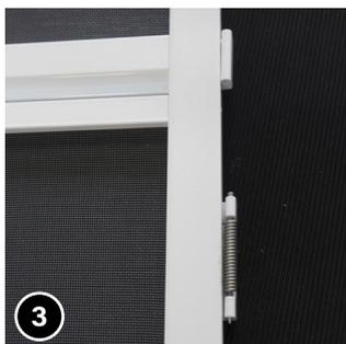
Danach nehmen Sie die Rahmentür ab und schrauben zunächst nur den Türschließer mit den drei beiliegenden Schrauben 3x20 am Türrahmen an (ggf. vorbohren). Anschließend können Sie die Rahmentüre wieder einhängen und das Ende der Feder im Türschließer in die Bohrung einstecken.
