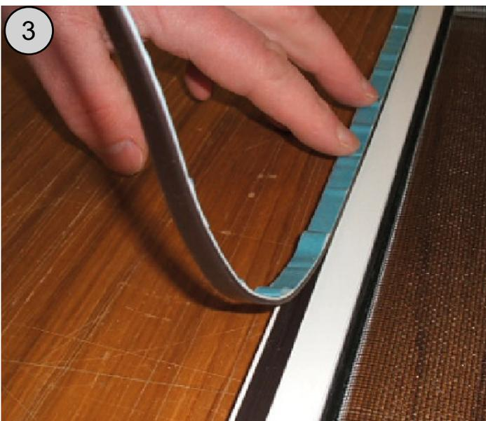
Nehmen Sie das beiliegende Magnetband und legen Sie dieses entsprechend der Polarisierung (+-) auf das bereits am Türrahmen befestigte Fliegengitter.
