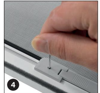
Schieben Sie die Schlitten für die Befestigung der Winkelaschen in die Ecken des Rahmens. In jeder Rahmenecke soll ein Schlitten sein. Ermitteln Sie dann mit Hilfe eines Maßstabes die Mitte Ihres Rahmens in der Höhe. Markieren Sie die Mitte des Rahmens in der Höhe mit einem Stift (z. B. Bleistift).
