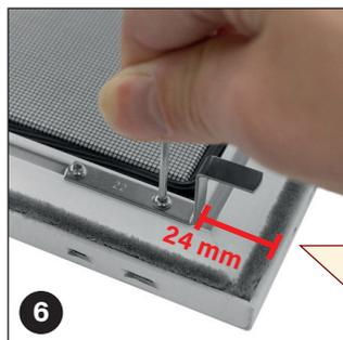
**ACHTUNG** Achten Sie dabei darauf, dass Sie die beiden Winkelaschen mit den längeren Schenkeln (1) oben befestigen und die Winkelaschen mit den kürzeren Schenkeln (2) unten am Rahmen anbringen! Oft ist ein Abstand von 24 mm von der Rahmenaußenkante oben und 17 mm unten geeignet. Je nach Passgenauigkeit und Einbausituation können die Abstände verändert werden.
