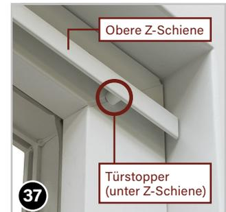
Das Bild oben zeigt die angeklebte Z-Schiene (70) mit Türstopper (5) (verdeckt unter der Z-Schiene) am Türrahmen.
