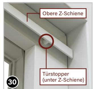
Das Bild oben zeigt die angeschraubte Z-Schiene (70) mit Türstopper (5) (verdeckt unter der Z-Schiene) am Türrahmen.
