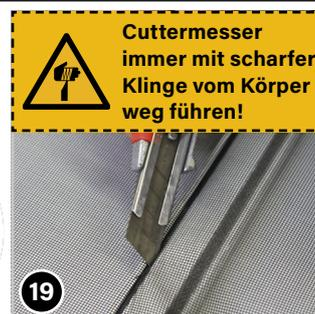
Mit Cuttermesser kurz oberhalb der Gummikeder-Nut am Rand auf dem Gummikeder 9 entlangfahren und das Fliegengitter 10 abschneiden.
