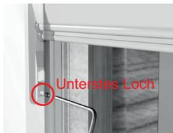
● **Optional:** Nehmen Sie die beiden übrigen Madenschrauben (7) und schrauben Sie damit die Kopfteile (10) von innen zusätzlich an. I. d. R. Reicht die normale Verschraubung aus.
