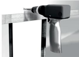
● Mit einem Bohrer Ø 6 mm Löcher bohren und Dübel einstecken.
