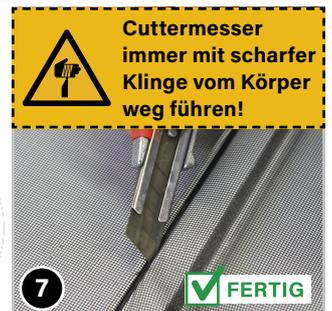
Mit einem scharfen Cuttermesser, kurz oberhalb der Gummikeder-Nut, am Rand des Rahmens entlang, das Fliegengitter abschneiden.
