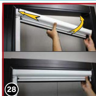
Rollokasten mit aufgesteckter Endkappe DX/R ⑩ in die bereits verschraubte Endkappe einstecken. Rollokasten an die exakte Position bringen.
