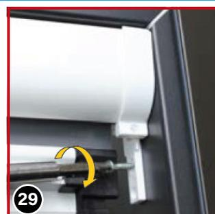
Wie vorher die Führungsschiene von unten in die Endkappe ⑩ einstecken. **Überprüfen, ob Rollokasten und Führungsschiene zueinander im 90° Winkel sind!** Bohrlöcher (und Position der Endkappe) markieren. Löcher Ø 6 mm bohren (außer bei Holz). Nun Dübel einstecken, Rollokasten wieder einklemmen und Endkappe mit Schrauben 3,5x40, sowie Führungsschiene mit Schrauben 4x40 anschrauben.
