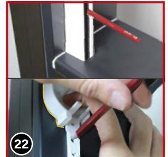
Markieren Sie die Bohrstellen für die Befestigung der Führungsschiene und Endkappe ⑩. Bei der Endkappe im oberen Bereich reicht es aus, wenn Sie diese im mittleren (länglichen) Loch anschrauben.
