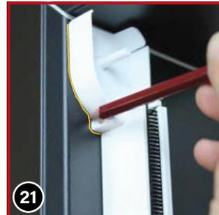
Fahren Sie mit einem Stift den Rand der Endkappe ⑩ am Mauerwerk nach, damit Sie beim Anschrauben genau wissen, wo diese nach dem Bohren angeschraubt werden muss.
