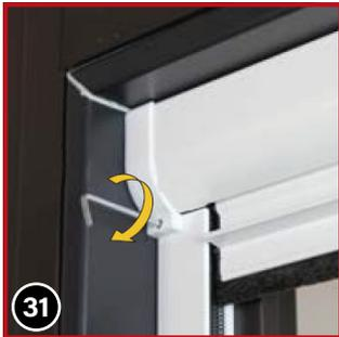
Für eine zusätzliche Befestigung können Sie die Endkappen **(10)** mit einer Madenschraube **(7)** von vorne am Rollokasten mittels Sechskantschlüssel **(50)** fixieren. Sie können diesen Schritt auch überspringen, wenn der Kasten oben am Fenstersturz anliegt.
