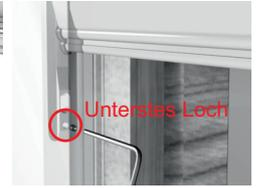
● Ab hier ist eine zweite Person hilfreich. Rollokasten und Führungsschienen zusammenstecken (Führungsschiene in Zunge des Kopfteiles) und stellen Sie diese an die vorgesehene Position. Schrauben Sie beides durch die Löcher der Führungsschienen an. Je nach Fensterart muss ggf. vorgebohrt werden.
