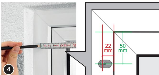
Mesurez maintenant les positions des verrous supérieurs ⑤. Contrairement aux verrous inférieurs, ceux-ci sont placés latéralement sur le cadre de la fenêtre. À partir du bord supérieur de l'ouverture de la fenêtre, mesurez 50 mm vers le bas et marquez ce point. Ensuite, mesurez 22 mm vers l'extérieur et marquez la position finale du premier verrou supérieur. Répétez ces étapes pour installer le verrou supérieur de l'autre côté.
