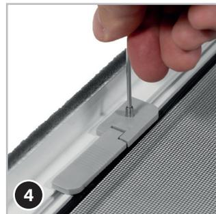
Serrez maintenant la vis située dans la poignée à l'aide de la clé hexagonale (5), avec précaution – vissez la vis uniquement jusqu'à ce qu'elle soit presque invisible dans la poignée. Cela fixera la poignée en position.
