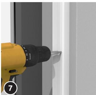
Nun den Montagerahmen mit den beiliegenden Schrauben 4 x 55 (12) festschrauben.
