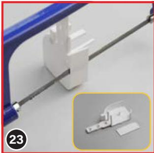
Sciez ou coupez l'arrière des embouts (10) au niveau de la zone perforée afin que le caisson puisse ensuite reposer à plat contre le mur.
