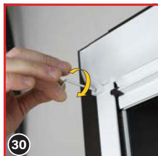
Pour une fixation supplémentaire, fixer les embouts (10) avec une vis sans tête (7) par l'avant du caisson du store à l'aide d'une clé hexagonale (50). Alternative : visser la languette de l'embout sur le côté avec une vis sans tête (trou rond).
