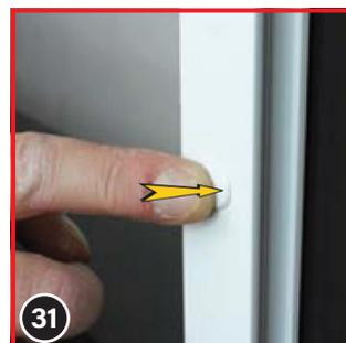
Obturer les trous de Ø 10 mm à l'avant des rails de guidage avec les bouchons de recouvrement des trous (32).
