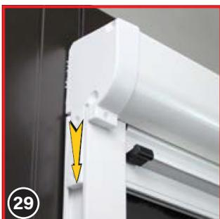
La « languette » des embouts (10) est alors insérée dans la rainure arrière (extérieure) des rails de guidage.
