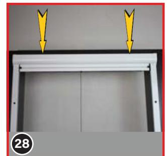
Insérez le caisson du store avec les embouts (10) fixés par le haut sur les rails de guidage.
