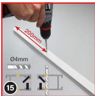
Placez les rails de guidage avec les brosses anti-vent en miroir l'un par rapport à l'autre (voir illustration) – pour les brosses standard, l'orientation n'a pas d'importance. Percez un trou de Ø 4 mm à travers les deux parois des rails de guidage, à environ 200 mm (20 cm) des extrémités.
