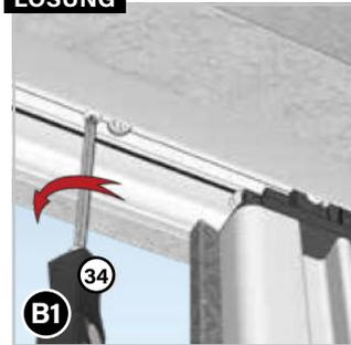
Lockern Sie dazu zuerst die Befestigungsschrauben 27 28 in den Justierblöcken 15 und dann die großen Gewindeschrauben. Montieren Sie die Z-Schiene so, dass sich diese parallel zum Boden befindet.
