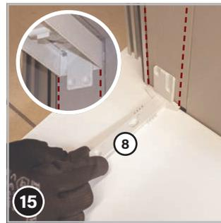
Fixez les supports de boîtier (7) au sol parallèlement au rail de guidage (2) (voir les lignes rouges sur l'image ci-dessus). Commencez par déterminer leur position (tracez si nécessaire).
