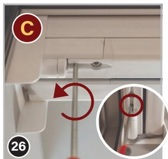
Ajustez la hauteur des rails de poignée ouverts à l'aide de la vis de réglage « C ». Il ne doit y avoir aucun espace entre les rails de poignée et le sol.
