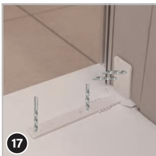
b) ... ou le fixer au sol avec des vis. Selon la surface, percez d'abord et insérez des chevilles si nécessaire.
