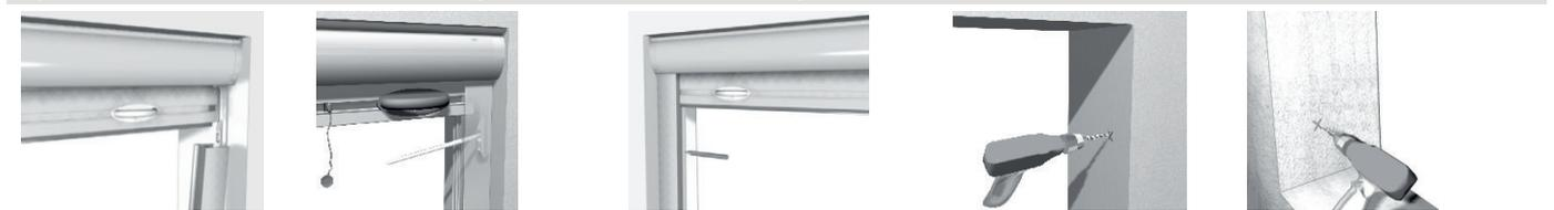
● Ab hier ist eine zweite Person hilfreich. Rollokasten und Führungsschienen zusammenstecken (Führungsschiene in Zunge des Kopfteiles) und stellen Sie diese an die vorgesehene Position. Markieren Sie danach die Bohrstellen mit einem Stift.
