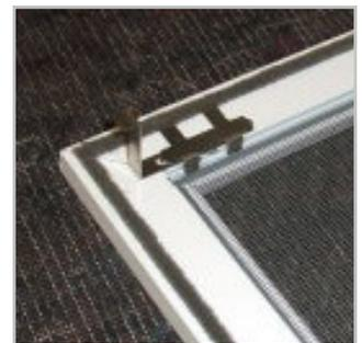
Fertig montiertes Profil mit Einclipshalter und Winkellasche.
