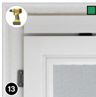
13 - Bei **Z-Endanschlag** ⑥: mit Bohrschrauben 3,5x16 ③ am Türrahmen anschrauben.
