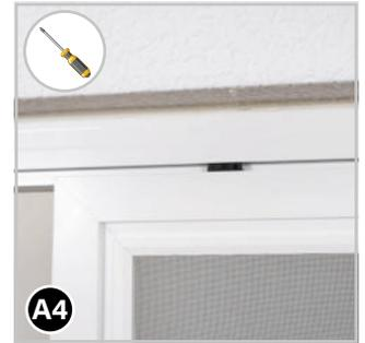
Hängen Sie den Schiebetürflügel über die Laufwagen (wie in den Montageschritten 9-14 erklärt) wieder in der Laufschiene ein. Überprüfen Sie die Positionierung der Schiebetür.
