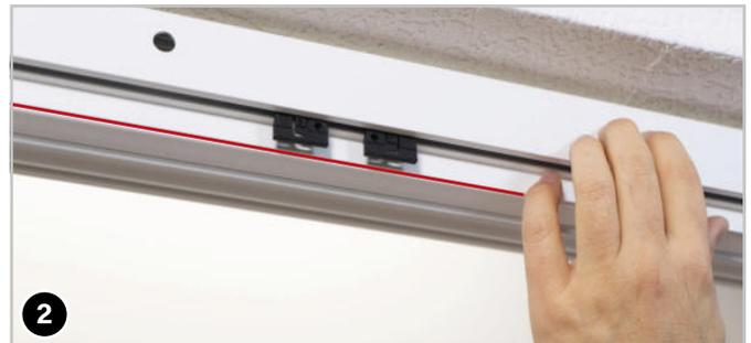
Positionieren Sie die Laufschiene (A) so, dass die Unterkante der Laufschiene an der Unterkante des oberen Türrahmens anliegt (rote Linie im Bild). Normalerweise befindet sich die Laufschiene dann in einer exakt waagrechten Position.
