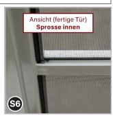
Den Sitz der Sprosse @ auf der inneren und äußeren Seite der Türe kontrollieren und ggf. mit Gummihammer nachklopfen. Montageschritt § bis § mit der zweiten Türe wiederholen. Dann zu Montageschritt 2 auf Seite 4 zurückkehren und fortfahren.
