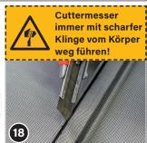
Mit Cuttermesser kurz oberhalb der Gummikeder-Nut am Rand auf dem Gummikeder (9) entlangfahren und das Fliegengitter 6 abschneiden. Dann bei zweiter Türe ebenso vorgehen.
