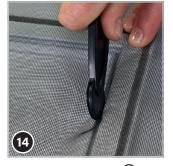
Zuerst die Fliegengitter (10) mit Kedereindrücker 5 ohne Gummikeder (9) in Nut der Schiebetür vordrücken. Das erleichtert das Einziehen mit Netz.
