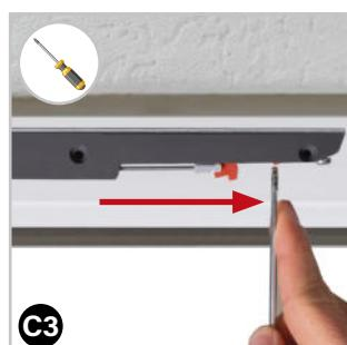
Greifen Sie mit dem Schraubendreher in den Haken des Verschlusses. Normalerweise "spüren" sie dies durch den Widerstand, wenn sie den Schraubendreher etwas nach rechts oder links bewegen.
