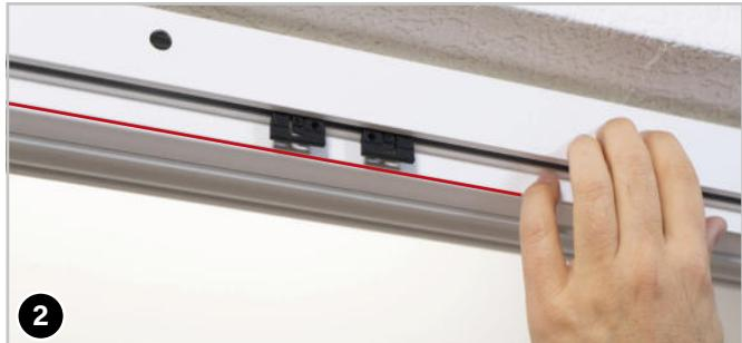
Positionieren Sie die Laufschiene (A) so, dass die Unterkante der Laufschiene an der Unterkante des oberen Türrahmens anliegt (rote Linie im Bild). Normalerweise befindet sich die Laufschiene dann in einer exakt waagrechten Position.
