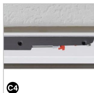
Ziehen Sie den Schraubendreher von links nach rechts/rechts nach links (je nach DIN-Seite). Der Haken rastet durch ein leichtes Klicken ein und wird dabei geöffnet. Nun sollte der Verschluss funktionieren.
