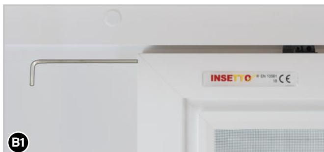
Mittels des beiliegenden Spezialschlüssels TX **2** (oder eines langen Schraubendrehers) können Sie die Neigung der Laufwagen von außen an der Stirnseite durch Auf- und Zudrehen der Stellschraube anpassen. Achten Sie darauf die Stellschraube langsam und nicht zu weit auf-/zuzdrehen. **ACHTUNG:** Überprüfen Sie nach einer Umdrehung durch die Bedienung des Schiebetürflügels immer gleich, ob eine weitere Umdrehung wirklich notwendig ist!
