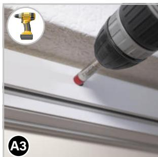
Lösen Sie die mittlere und eine der beiden äußeren Bohrschrauben **3**, damit Sie die Laufschiene in eine waagrechte Position bringen können. Schrauben Sie diese danach wieder an.
