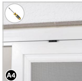
Hängen Sie den Schiebetürflügel über die Laufwagen (wie in den Montageschritten 9-14 erklärt) wieder in der Laufschiene ein. Überprüfen Sie die Positionierung der Schiebetür.
