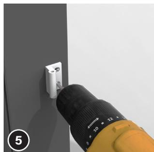
Die Scharnierunterteile mit den mitgelieferten Schrauben 3 x 16 (13) festschrauben.
