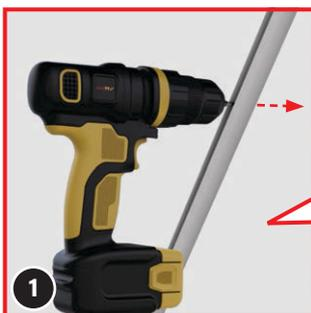
Bohren Sie mit einem Ø 4 mm Bohrer 2-3 Löcher in die Führungsschienen. Entnehmen Sie die korrekten Abstände aus dem nebenstehenden Bild.
