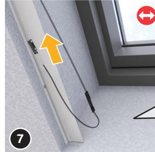
Setzen Sie den ersten Justierblock (15) in den unteren Teil der Führungsschiene ein. Legen Sie dazu den Justierblock in die Aussparung in der Führungsschiene und schieben Sie ihn nach oben, sodass er nicht mehr herausfallen kann. Achten Sie dabei darauf, dass die Schrauben nach oben zeigen.
