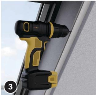
Bohren Sie entsprechend Ihrer Markierungen Löcher in die Wand. Befestigen Sie darin die Führungsschienen mit den beiliegenden Schrauben (5) und Dübeln (6).
