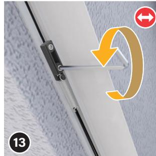
Lösen Sie den oberen Justierblock mithilfe des Sechskantschlüssels.
