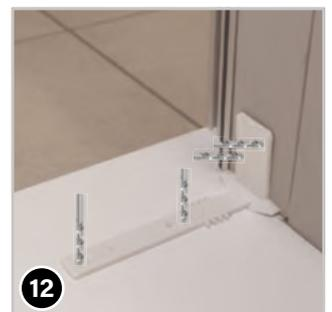
a) **Stein/Mauerwerk:** jetzt die Dübel einstecken
