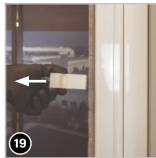
Die Halterungen der Ausgleichsschiene am Kasten jetzt ganz entfernen.
