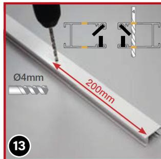
Im Abstand von ca. 200 mm (20 cm) zum anderen Ende der Führungsschienen ein weiteres Loch  $\varnothing$  4 mm durch beide Wandungen bohren. Bei Führungsschienen mit einer Länge über 150 cm machen Sie eine weitere Bohrung  $\varnothing$  4 mm in der Mitte.
