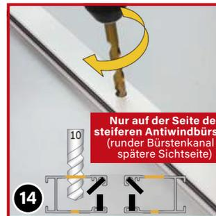
Die Löcher mit Bohrer  $\varnothing$  10 mm vergrößern. Hier werden später die 10 mm großen Bohrungsabdeckstöpfe (32) eingesteckt. Bei Standardbürste ist es egal, auf welcher Seite Sie die 10 mm Bohrung machen.
