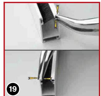
Wenn die Führungsschienen später nicht direkt auf der Fensterbank aufstehen, dann zwicken Sie die Enden derselbigen mit einer Zange zusammen. Dies verhindert das Herausrutschen der Bürsten.
