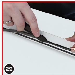
Nun die Bürstendichtung mithilfe des Eindrückerwerkzeugs (16) in die Nuten der Führungsschienen und des Abschlussprofils eindrücken. Die Position der Bürsten wird dadurch bestimmt, wie das Rollo an Ihrer Dachfensterschräge abschließt - z.B. auf einer Fensterbank aufliegt. Trennen Sie überstehende Bürsten mit einer Schere ab.
