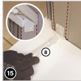
Parallel zur Führungssch. (2) (siehe rote Linien im oberen Bild) die Kastenhalterungen (8) am Boden anbringen. Dazu zuerst die Position ermitteln (ggf. anzeichnen).
