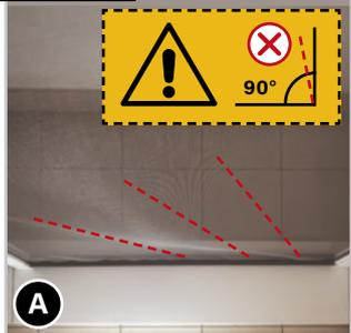
Dies ein Zeichen dafür, dass sich Rollokasten (1) und Bodenführung (Kettenglieder) im geöffneten Zustand nicht im 90°-Winkel befinden.
