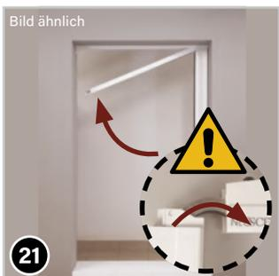
Anschließend vorsichtig die Ausgleichsschienen nach oben klappen und in den Rollokästen ohne Druck einstecken.
