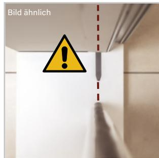
Verkleben Sie diesen anschließend zwischen den Rollokästen am Boden. Die Position muss so gewählt sein, dass sich die Griffschiene in Endposition exakt senkrecht befindet.
