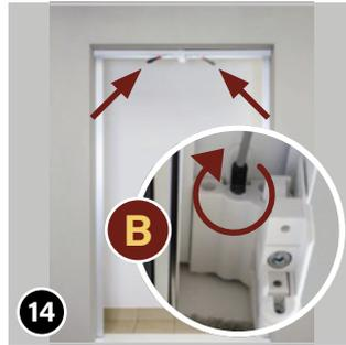
Anschließend, wie oben im Bild zu sehen, die Schrauben der Abdeckkappen (7) festziehen. Dazu den beiliegenden Sechskantschlüssel (10) verwenden.
