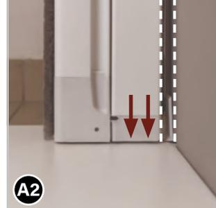
Anschließend den Rollokasten (1) wieder unten in der Kastenhalterung (8) fixieren. Erneut den Lauf des Rollos testen.
