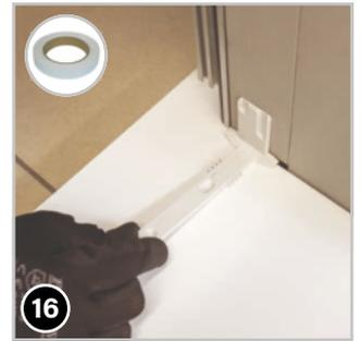
**ACHTUNG** Es gibt hier zwei Befestigungsmöglichkeiten: a) Entweder **mit Klebeband** (3) am Boden akleben ...
