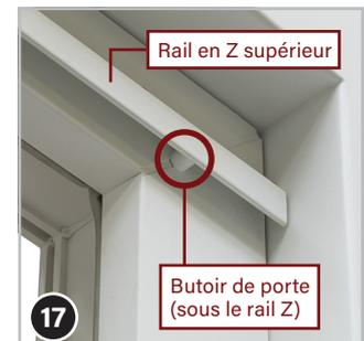
L'image ci-dessus montre le rail en Z (10) collé avec le butoir de porte (1) (caché sous le rail en Z) sur le cadre de la porte.
