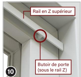
La photo ci-dessus montre le rail en Z (10) vissé avec l'arrêt de porte (1) (caché sous le rail en Z) sur le cadre de la porte.
