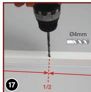
Bohren Sie abschließend noch ein drittes Loch, in der Mitte des U-Profils Ø4 mm leicht außermittig (nicht die Nut anbohren!).
