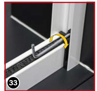
Nun die Madenschraube 7 im Führungsstopper 22 auf die Führungsschiene mit dem mitgelieferten Sechskantschlüssel 50 festschrauben.
