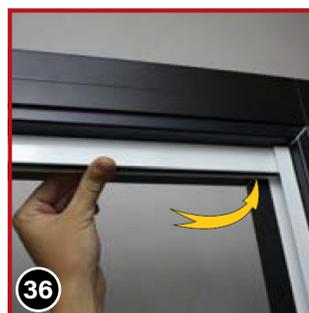
Obere Führungsschiene ganz in die Endkappe des Rollokastens aufstecken und auf der anderen Seite diese zeitgleich im U-Profil nach oben gegen den Sturz/die Decke drücken.
