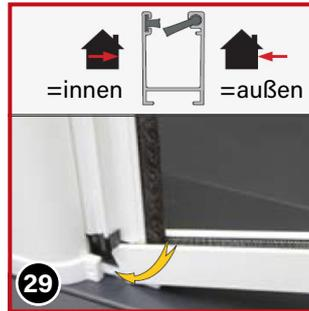
Schieben Sie die untere Führungsschiene leicht gekippt mit der hinteren Nut auf die Zunge der angeschraubten Endkappe auf.
