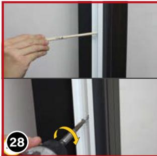
Bohren Sie die Löcher und stecken Sie die Dübel ein (Hinweise dazu Schritt 25).
