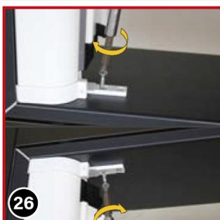
Schrauben Sie den Rollo durch das mittlere Loch der aufgesteckten Endkappen (10) mit den Schrauben 4x40 in der Türleibung fest.
