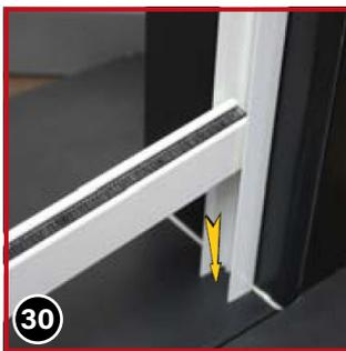
Die Führungsschiene im gekippten Zustand auf der anderen Seite zwischen das U-Profil schieben.
