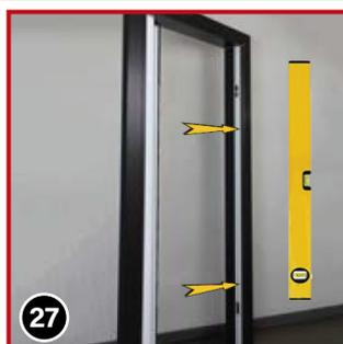
Stellen Sie nun das U-Profil mit der Nut näher nach innen (in welcher auch die Haken (21) eingeschoben sind) exakt gegenüber der Griffschiene des Rollos in die Türleibung.
