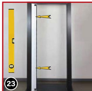
**TIPP** Ab hier am besten zu zweit arbeiten. Bringen Sie den ersten Rollokasten in die exakte Position. Durch die Klemmfeder (31) lässt sich der Kasten dabei etwas einklemmen.
