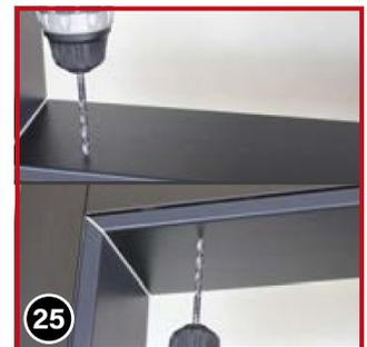
Bohren Sie an den markierten Stellen je ein Loch Ø6 mm und stecken Sie die mitgelieferten Universal-Dübel ein.
