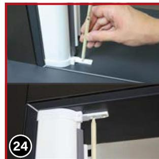
Wenn sich der Rollo an der richtigen Stelle und exakt in der Waage befindet, markieren Sie nun die Bohrstellen durch das mittlere Loch in den Endkappen (10) mit einem Stift.
