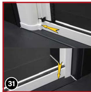
Anschließend die untere Führungsschiene ganz in die Endkappe 10 des Rollokastens aufstecken und zeitgleich auf der anderen Seite die Schiene im U-Profil nach unten auf den Boden drücken.
