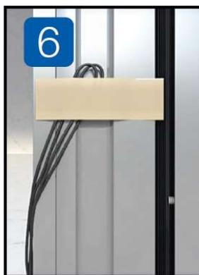
Schneiden Sie die Schutzstreifen des Gewebepakets und Spanners ab; entfernen Sie dann den Klebestreifen, der die Schnüre festhält.
