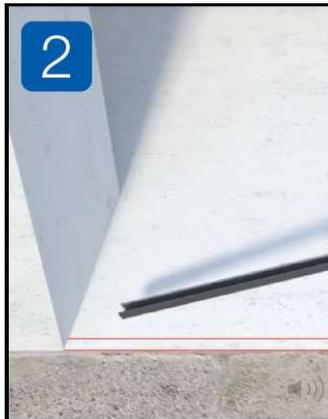
Befestigen Sie die obere Schiene mit geeigneten Schrauben und Dübeln. Befestigen Sie die untere Schiene, entfernen Sie die Schutzfolie vom Doppelklebeband und drücken Sie sie fest auf den Boden, um eine gute Haftung zu gewährleisten.
