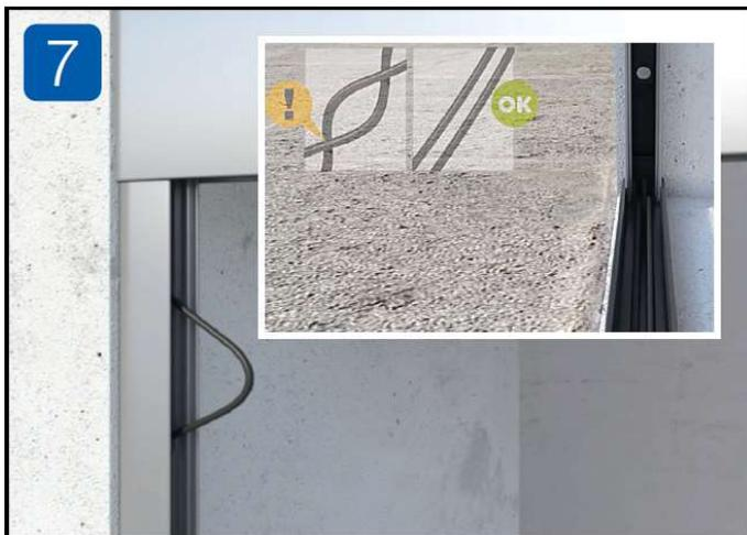
Das Profil mit den Spannern an der dem Gewebepaket gegenüberliegenden Wand anschrauben und sicherstellen, dass die Schnüre nicht überkreuzt werden.
