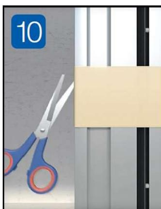
Entfernen Sie den Magneten vom Gewebepaket und schneiden Sie das restliche Klebeband ab.
