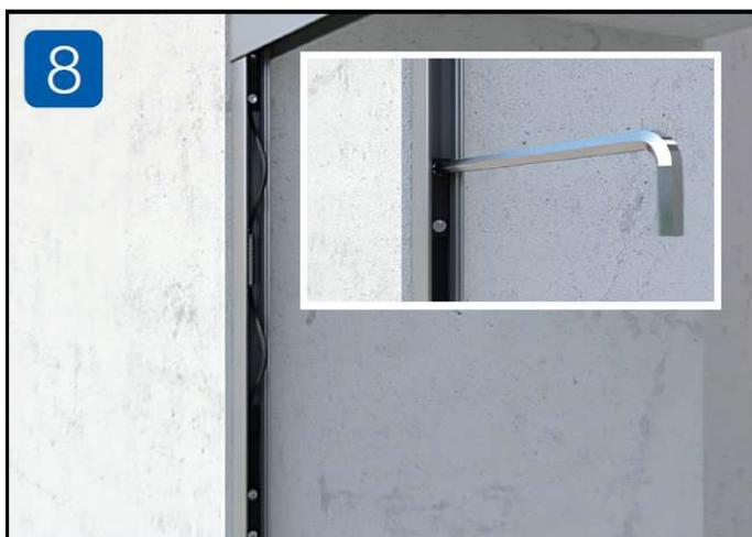
Spannen Sie die Schnüre mithilfe der Spanner im Innern der Profile, von unten beginnend, leicht an.
