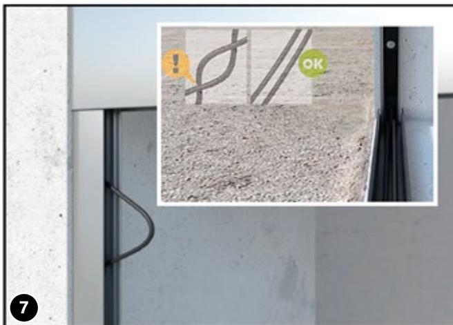
Nun das Anschlagprofil (4) auf der gegenüberliegenden Seite an der Wand befestigen. Dazu das Anschlagprofil von der Griffschiene des Plisseekastens (5) einfach abziehen.
