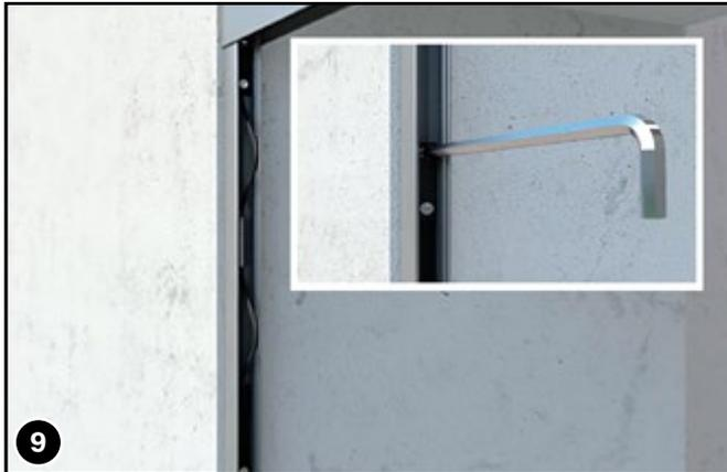
Nun die Schnüre mit den schwarzen Justierblöcken im Inneren des Anschlagprofils ④ spannen.
