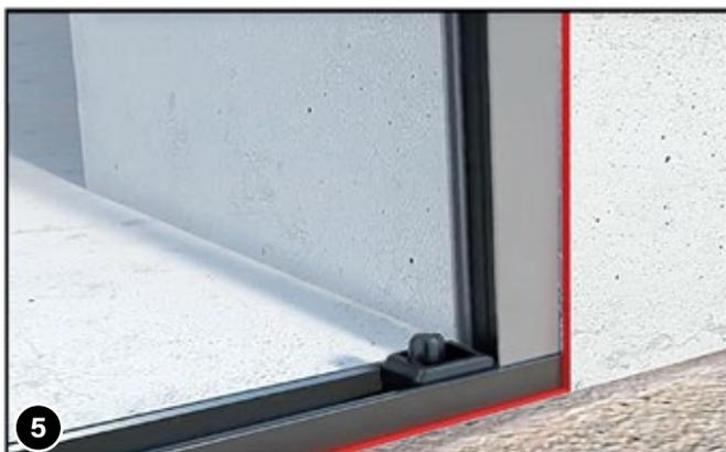
Bohren Sie das Wandprofil (3) vor. Zuerst mit einem kleinen Bohrer 2-3 Mal (z. B. Ø 4 mm) durch Magnet und Profil.
