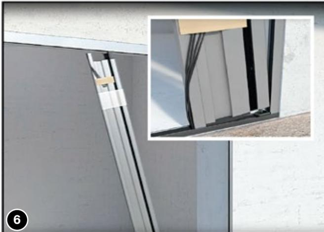
Befestigen Sie nun den Plisseekasten (5) im Magneten des Wandprofils (3).
