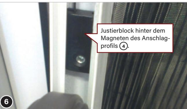
Justierblock hinter dem Magneten des Anschlagprofils (4).
