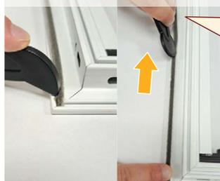
Posez la brosse sur une extrémité dans le canal de la rainure, puis enfoncez l'autre extrémité à l'aide de l'outil de pose de brosse inclus (32).
