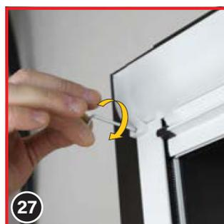
**Pour une fixation supplémentaire:** Fixez les embouts (10) au coffre du store à l'aide d'une vis sans tête (7), en vissant par l'avant à l'aide de la clé hexagonale (50).
