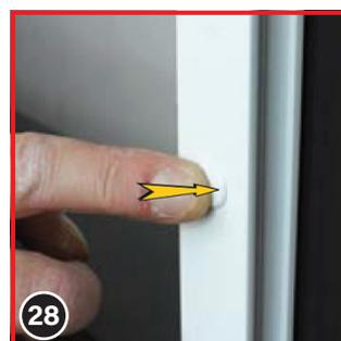
Fermez les trous Ø 10 mm sur la face avant des rails de guidage avec les bouchons de recouvrement (32).
