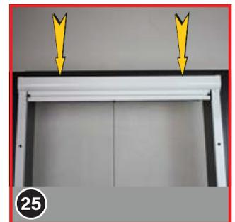
Fixez ensuite le coffre du store avec les embouts (10) installés, en l'enclenchant par le haut sur les rails de guidage.
