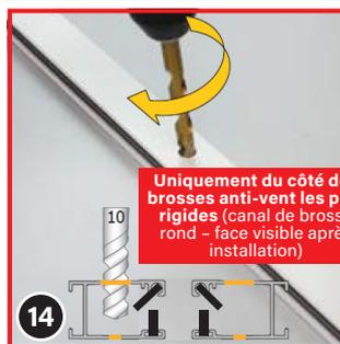
Agrandissez les trous avec un foret Ø 10 mm. Ces trous serviront à insérer plus tard les bouchons de recouvrement de 10 mm (32). Pour les brosses standard, peu importe de quel côté vous effectuez le perçage de 10 mm.
