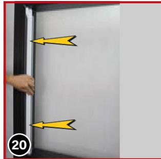
Schiene mit Endkappe SX/L ⑩ dort, wo das Rollo später angebracht werden soll, exakt senkrecht an der Wand positionieren. Die Rundung der Endkappe muss dabei vom Raum aus gesehen nach außen zeigen (Garten).
