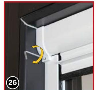
Für eine zusätzliche Befestigung können Sie die Endkappe (10) mit einer Madenschraube (7) von vorne am Rollokasten mittels Sechskantschlüssel (50) fixieren. Sie können diesen Schritt auch überspringen, wenn der Kasten oben am Fenstersturz anliegt.
