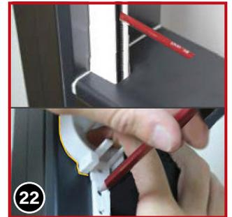
Markieren Sie die Bohrstellen für die Befestigung der Führungsschiene und Endkappe ⑩. Bei der Endkappe im oberen Bereich reicht es aus, wenn Sie diese im mittleren (länglichen) Loch anschrauben. **Die Schienen müssen exakt senkrecht sein!**
