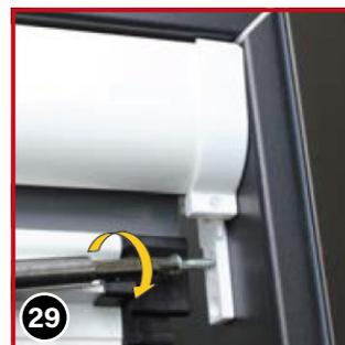
Wie vorher die Führungsschiene von unten in die Endkappe ⑩ einstecken. **Überprüfen, ob Rollokasten und Führungsschienen zueinander im 90° Winkel sind!** Bohrlöcher (und Position der Endkappe) markieren. Löcher Ø 6 mm bohren (außer bei Holz). Nun Dübel einstecken, Rollokasten wieder einklemmen und Endkappe mit Schrauben 3,5x40, sowie Führungsschiene mit Schrauben 4x40 anschrauben.
